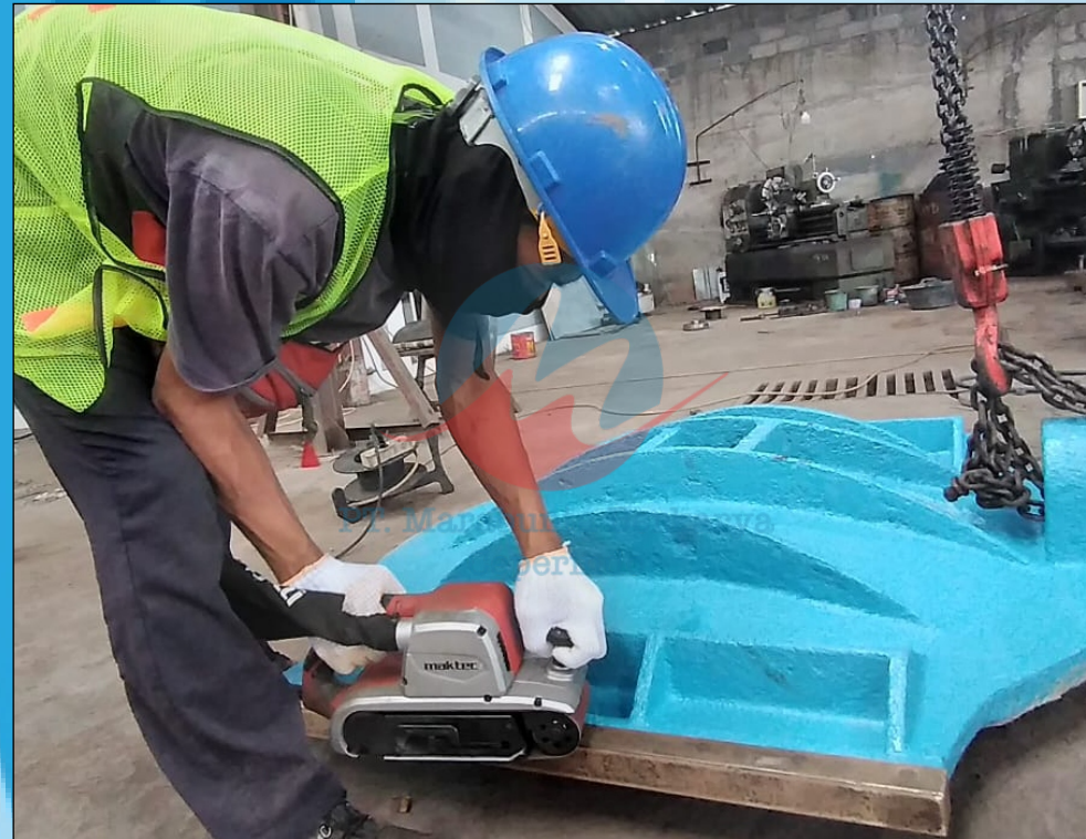
PERBAIKAN PINTU STOPLOG BENDUNGAN MALAHAYU
