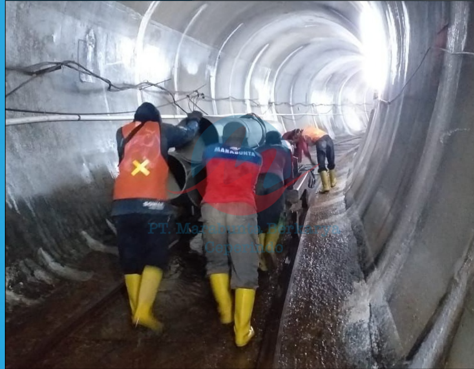
MOBILISASI PIPA HIDROMEKANIKAL
