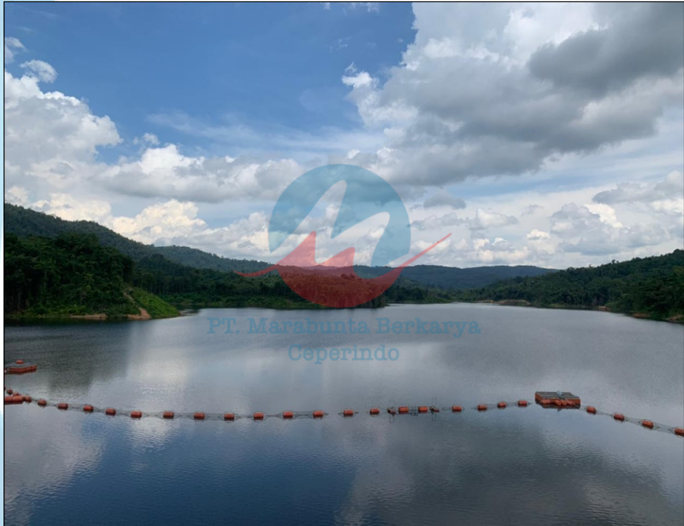
TRASHBOOM BENDUNGAN LADONGI
