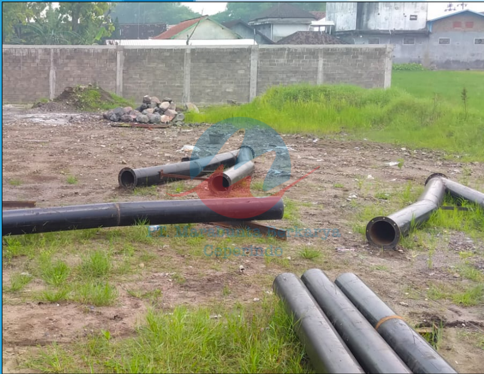
PROSES FABRIKASI ANJUNGAN BENDUNGAN AMERORO
