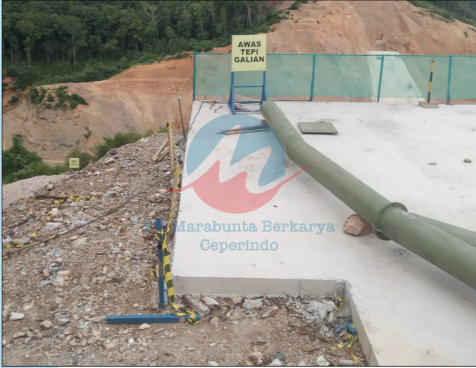
PROSES ASSEMBLY ANJUNGAN BENDUNGAN AMERORO
