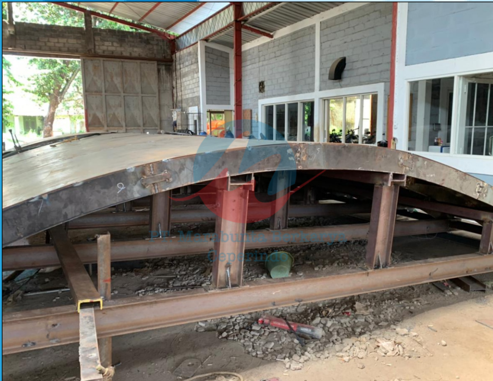
PENGERJAAN SIDE SLIDING FORM
