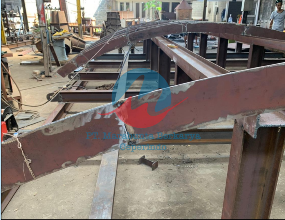
PENGERJAAN SIDE SLIDING FORM
