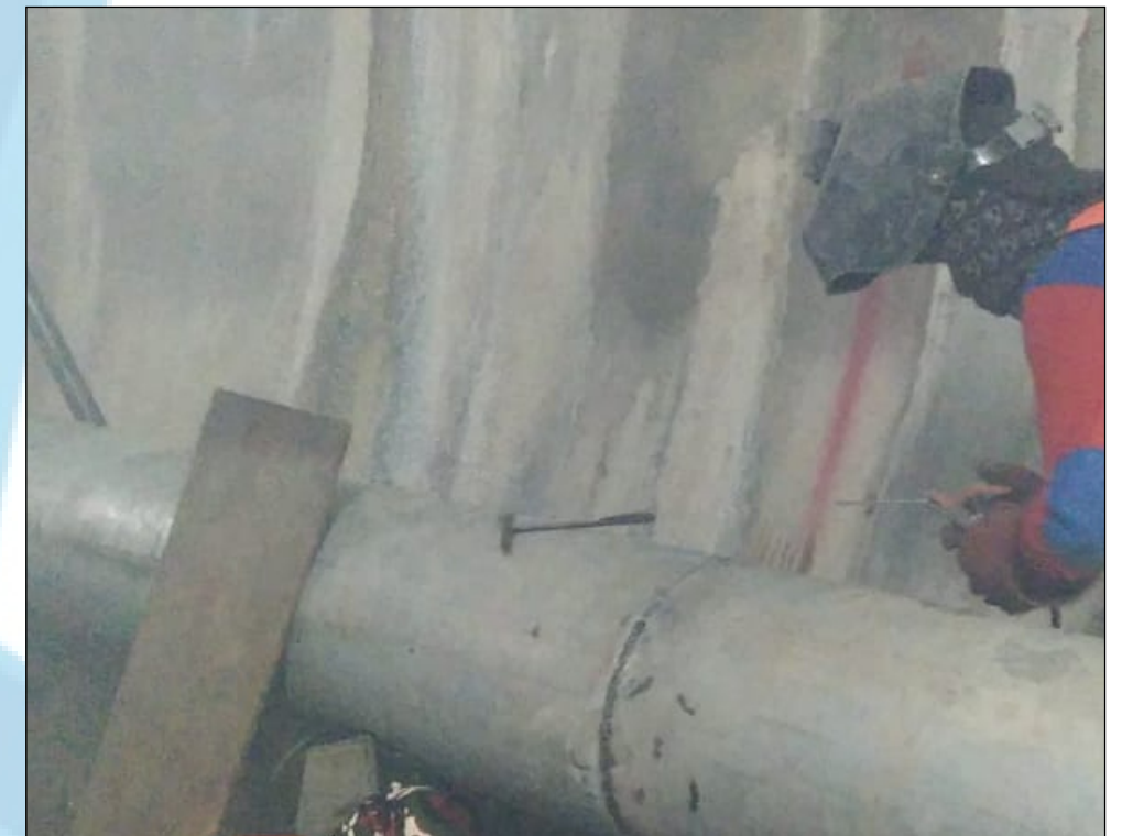
INSTALASI PIPA BENDUNGAN LADONGI
