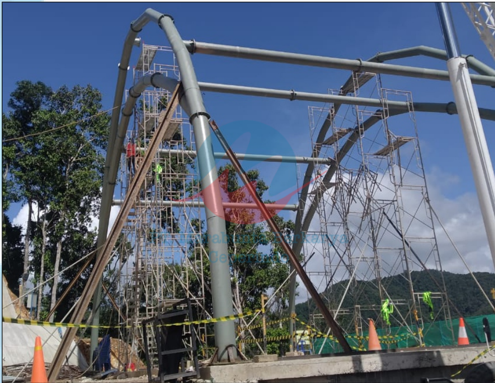
PROSES ERECTION ANJUNGAN BENDUNGAN AMERORO
