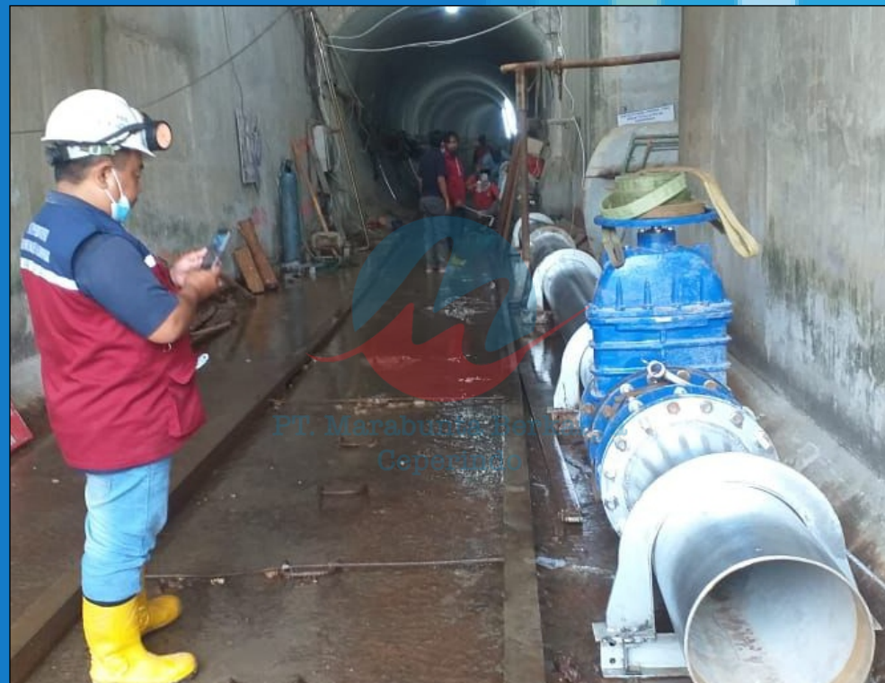
PEMASANGAN GATE VALVE BENDUNGAN LADONGI
