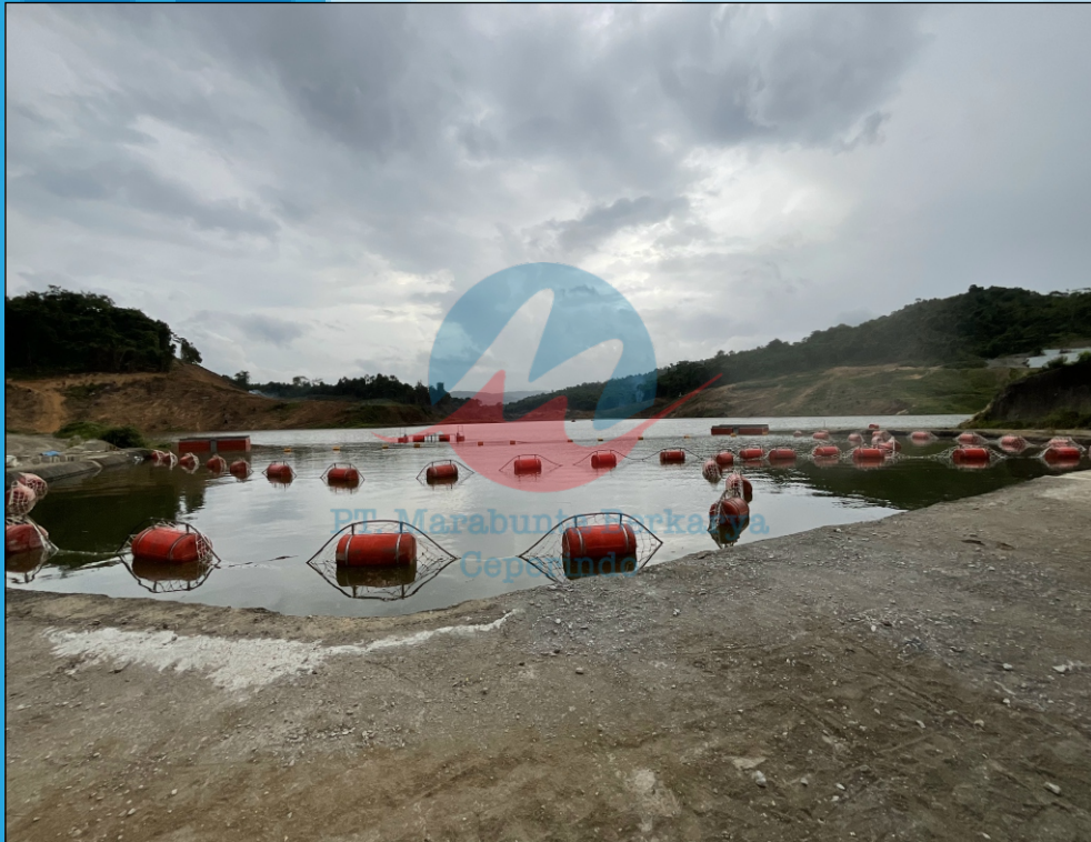
TRASHBOOM BENDUNGAN LADONGI
