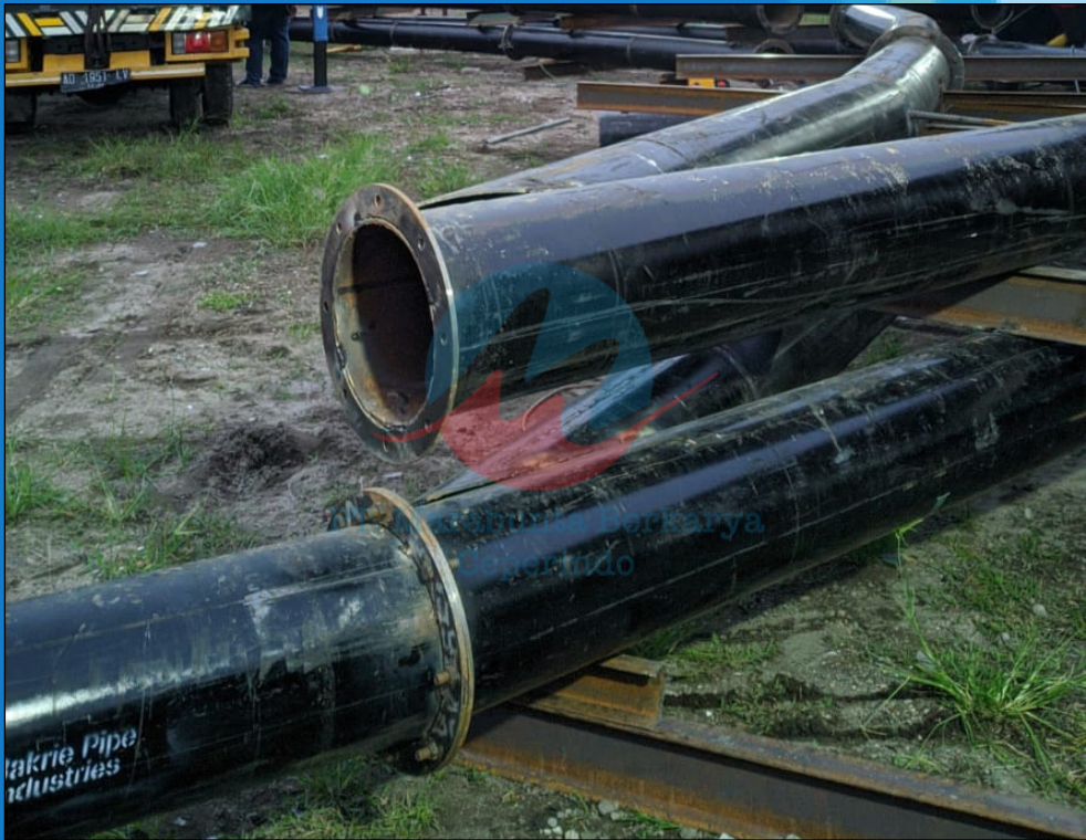
PROSES FABRIKASI ANJUNGAN BENDUNGAN AMERORO
