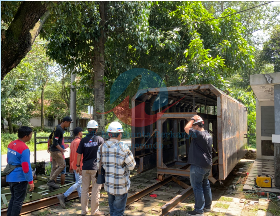
INSPEKSI METAL FORMWORK PROYEK D.I. LEMATANG
